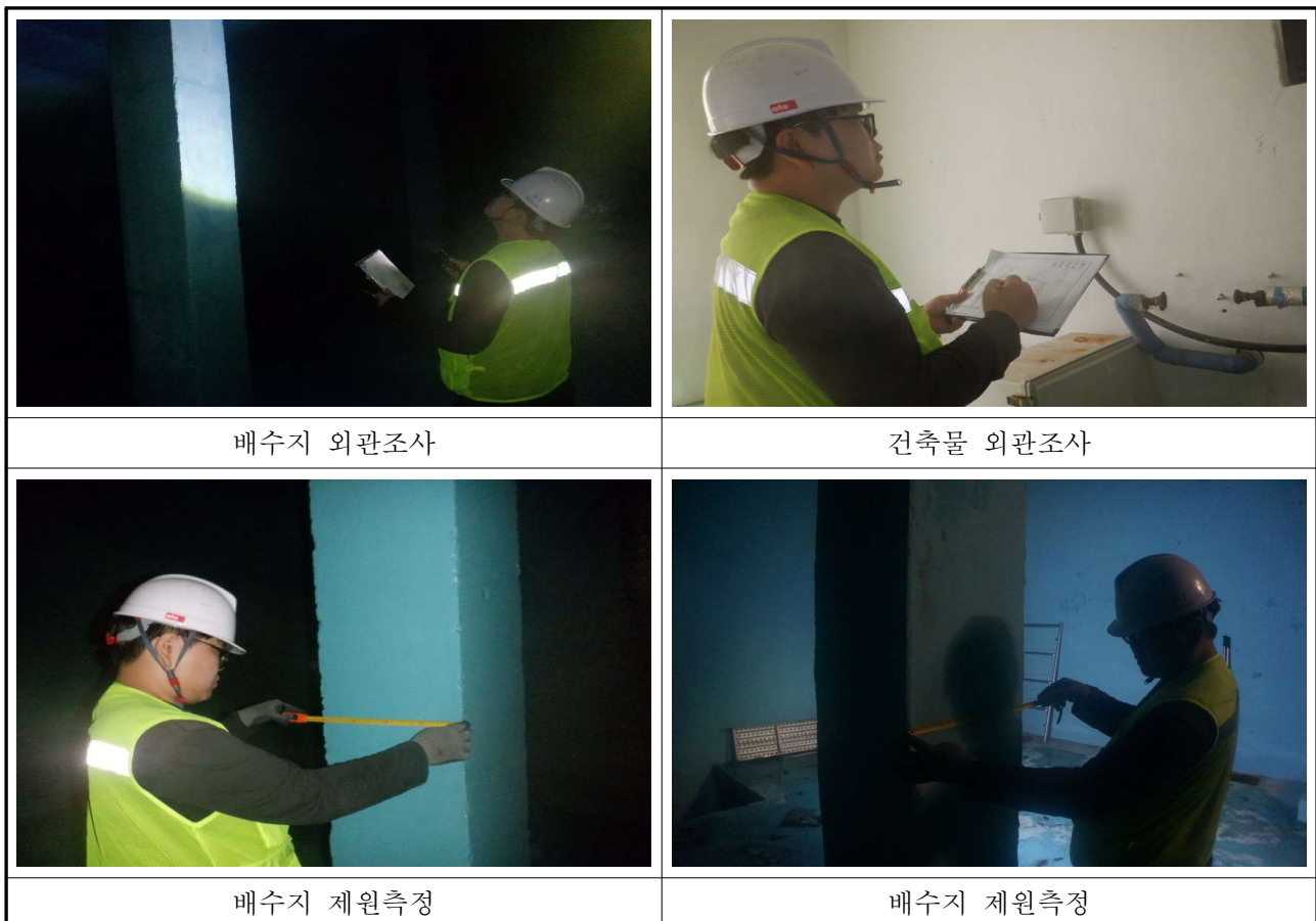
【사진 3.1】 시설물 외관조사
